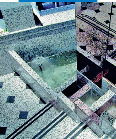
Ein Beispiel für die Verlegung von Granitplatten an Wand und Boden mit Keraquick S1 + Latex Plus - Caesaris Palace in Merseyside - Liverpool (GB)
