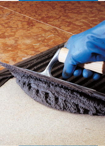
Spachteln von Fugen in Holzböden mit Nivorapid + Latex Plus
